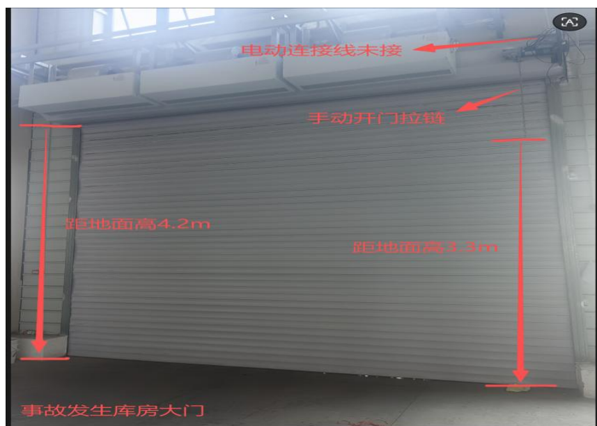
图1 事故发生库房大门
